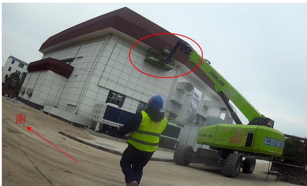
图1 作业人员被挤压在屋檐与操作台之间
