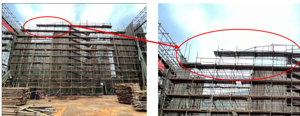
图1 3#风雨棚北侧内脚手架现场图
